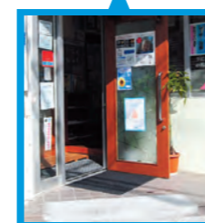
段差を無くした入口へのアプローチ
